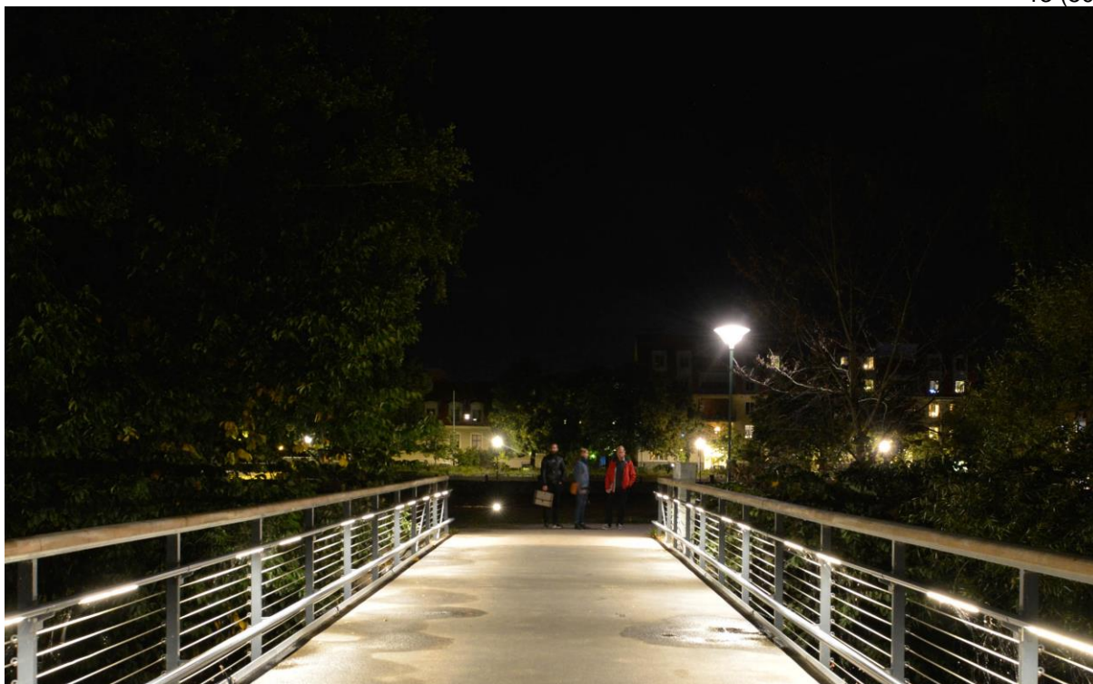
Bild 1. Kontrasten mellan den ljusa förgrunden och den mörka parken orsakar en barriär-effekt vilket bidrar till upplevelsen av mörker och otrygghet på väg in i parken. Barriären kunde minskas med bättre avskärmning av parklyktan samt en bättre balans mellan brons ljusnivå och parkens vertikala ljusnivåer. Foto: Tobias Olsson'
