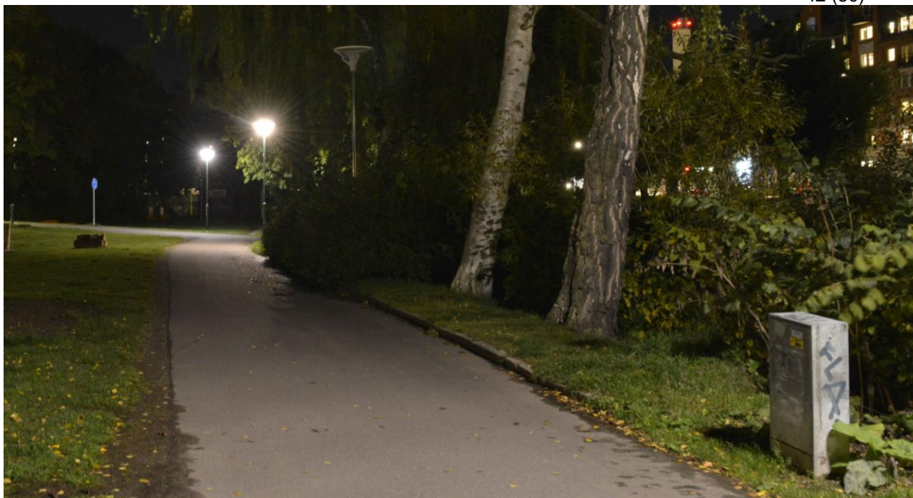
Bild 25. En nedsläckt lykta längs ett gång- och cykelstråk orsakar ett otryggt mörkt "hål" längs stråket. Trasiga armaturer åtgärdas snabbt efter rapportering för att motverka både otrygghet och ytterligare skadegörelse. Foto: Tobias Olsson
