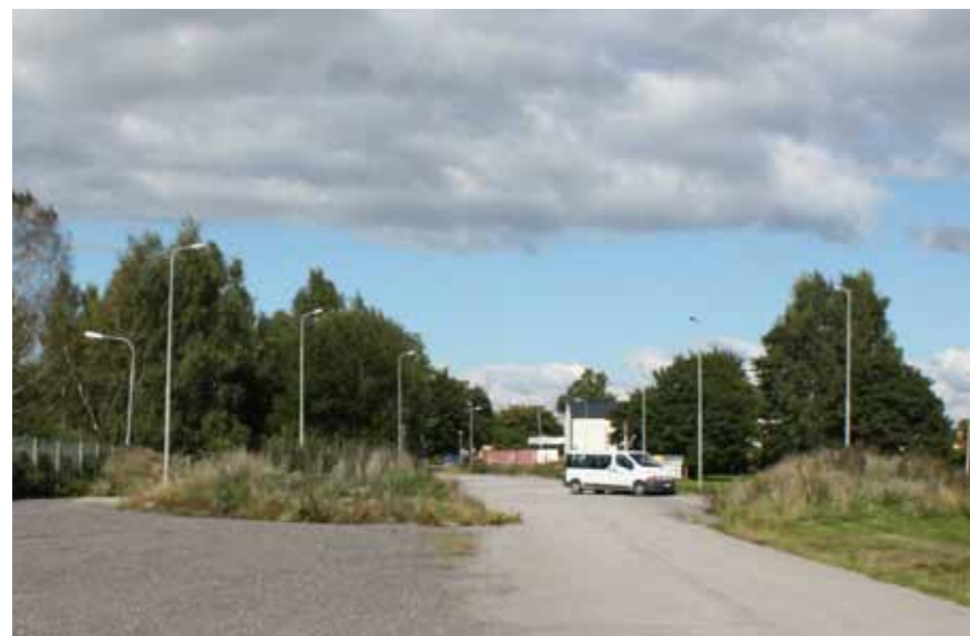
Kombinerade GC-vägar och bilvägar genom verksamhetsområde i anslutning till Himmelstalundsparken. Belysningsanläggningen präglas av ett industriellt uttryck.
