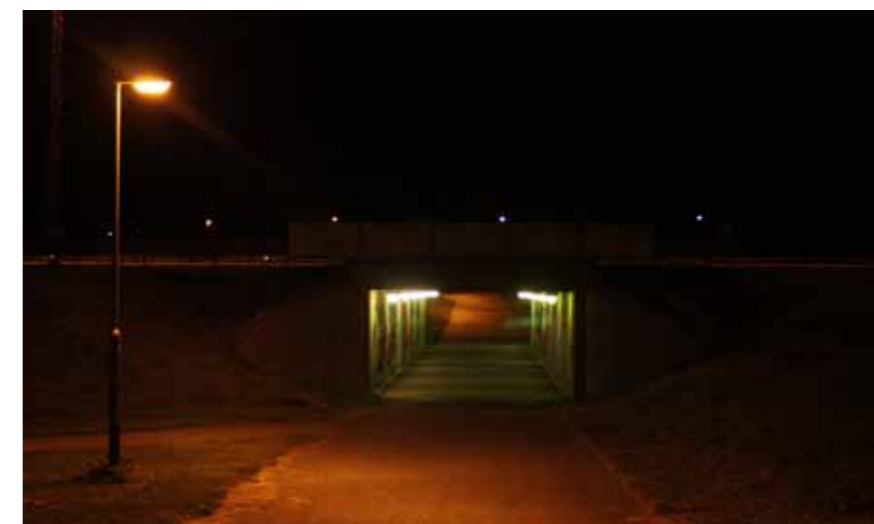
På kvällen är kontrasten mellan inne och ute mer jämn och man har god genomsikt och man kan se personen som man möter i tunneln. Upplevelsen av trygghetskänslan kan i detta fall även påverkas av klottret i tunneln samt av de robusta armaturerna som signalerar att det är en ruff miljö där vandalism kan förekomma.
