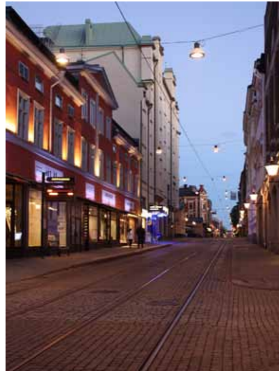
Drottninggatan med dubbla rader linspända armaturer, fasadljussättningar, vägg-hängda lyktor och spilljus från skyltfönster.
