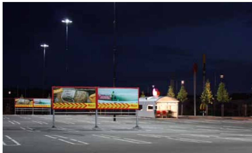
Parkeringsplats, Ingelsta köpcentrum. Med flera armaturer placerade på en stolpe skapas en visuellt ren och lättorienterad miljö.
