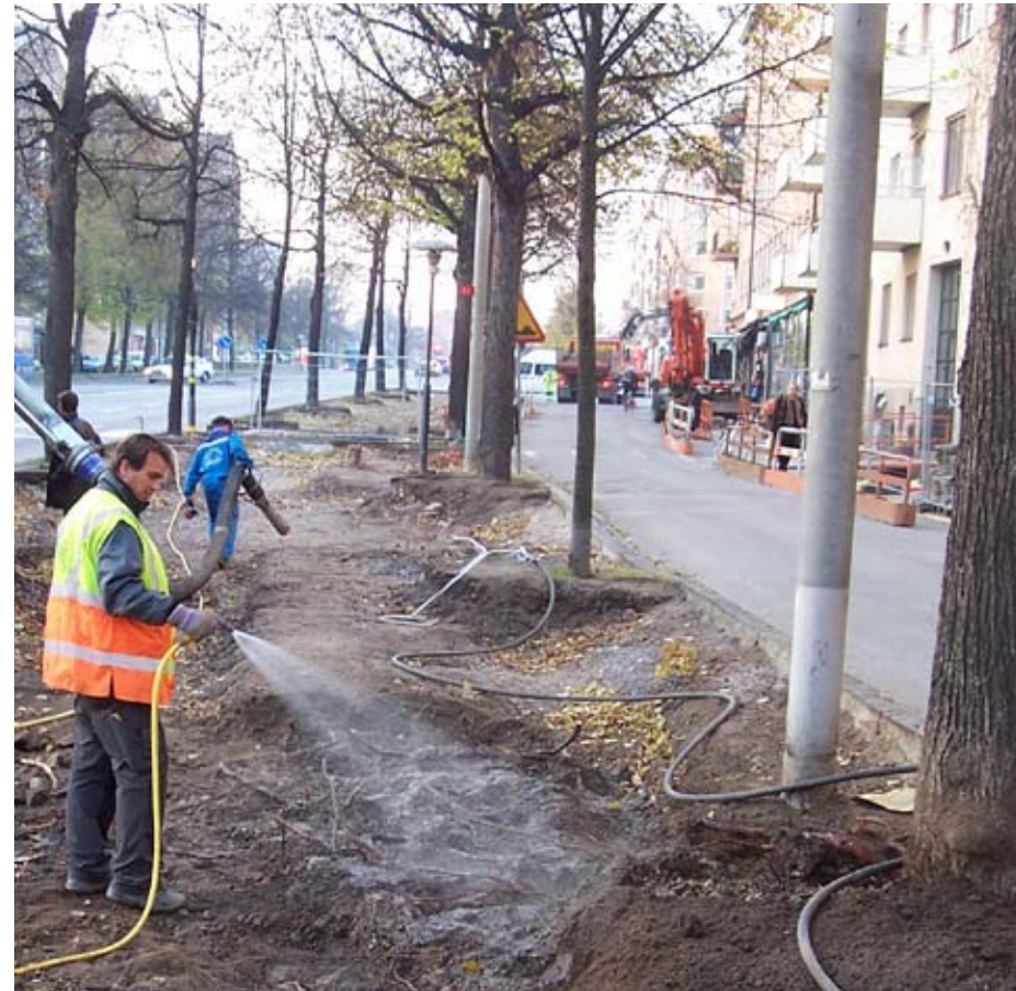
Frilagda rötter vid vakuumschaktarbeten bevattas som skydd mot torka. (Foto: Björn Embrén)
